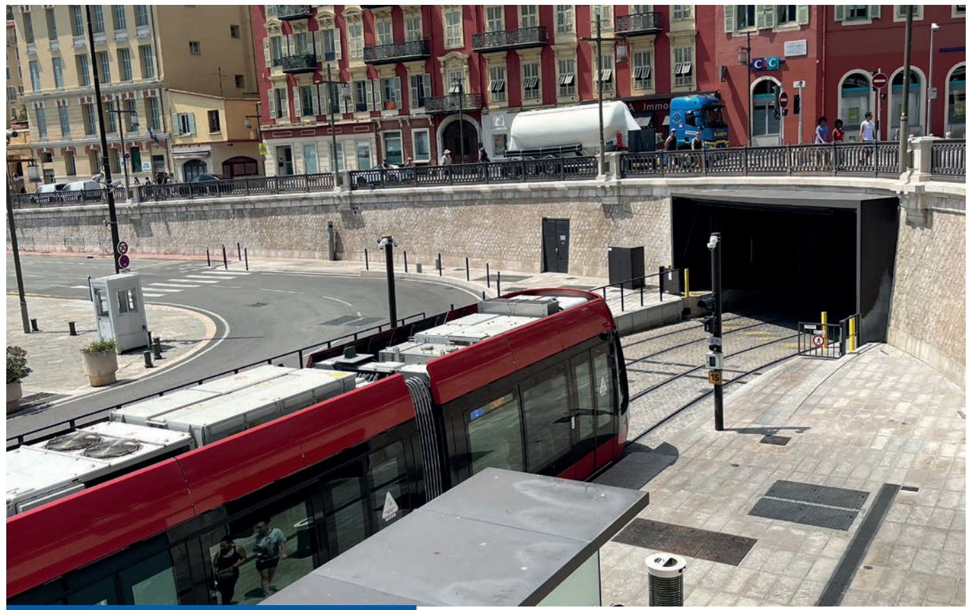
Station Port Lympia du tramway souterrain de Nice
