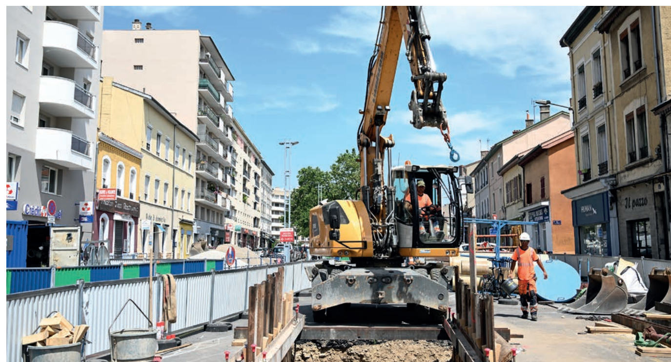
►► Dévoisement de réseau, rue Verlaine à Villeurbanne.
